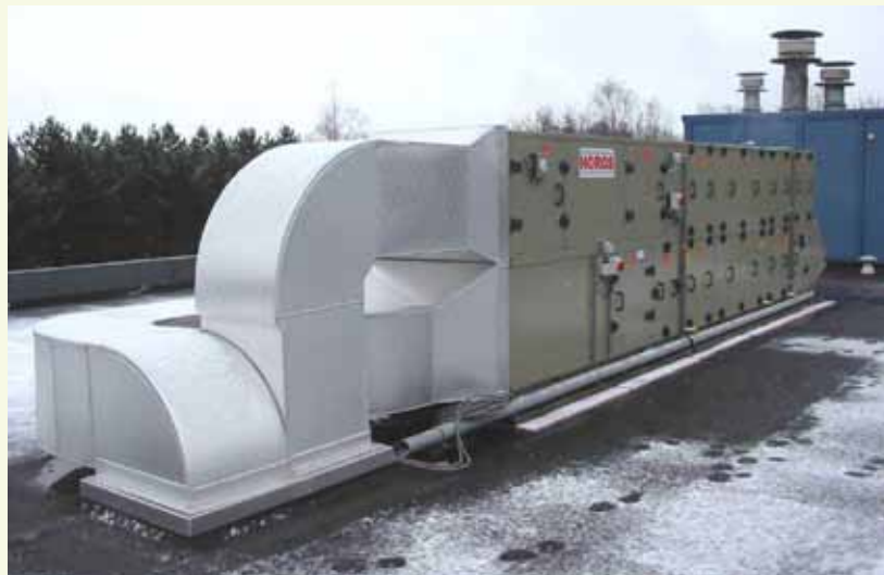
-Figuur 1- Centrale luchtbehandelingskast
